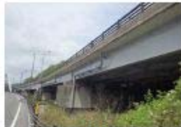
写真-4 阿蘇口大橋 (国道57号)
