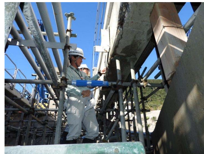
近接目視及び打音・触診点検
