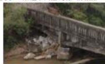
写真-2 平田・小樺線 田中橋
