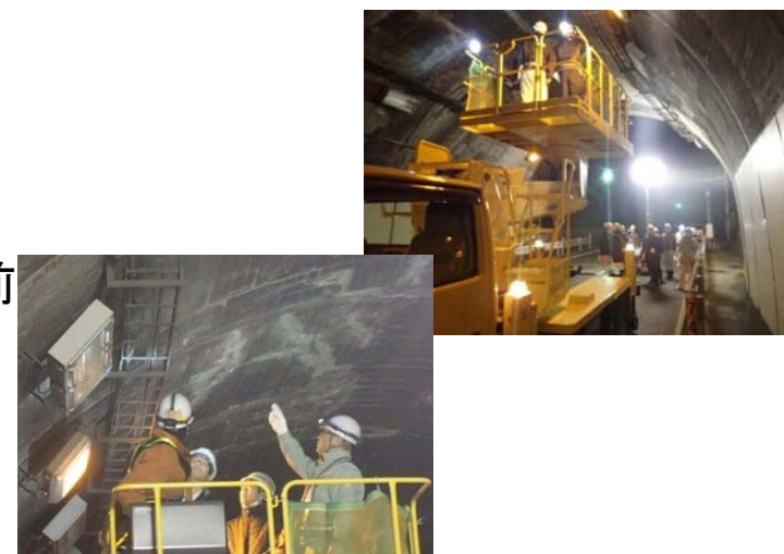
近接目視及び打音・触診点検
