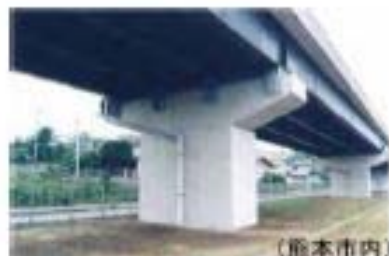
写真-3 国道3号 跨線部
