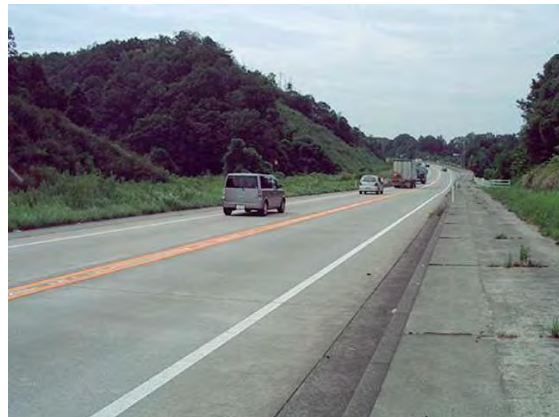
国道8号 石川県小松市※1 (普通コンクリート舗装)
