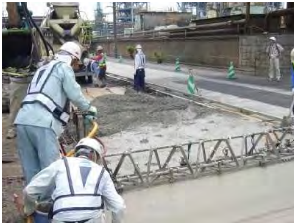
簡易フィニッシャによる施工事例
