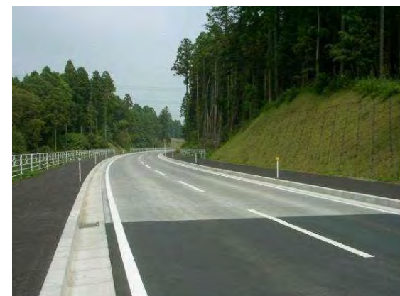
県道成田小見川鹿島港線 千葉県香取市※3 (ポーラスコンクリート舗装※4)
