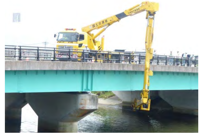
▲橋梁点検車(BT-400)による点検
