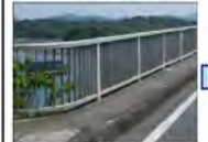
防護柵取替前
