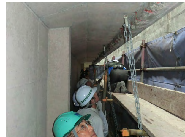
補修工事の説明状況
