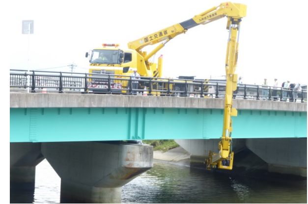
▲橋梁点検車(BT-400)による点検
