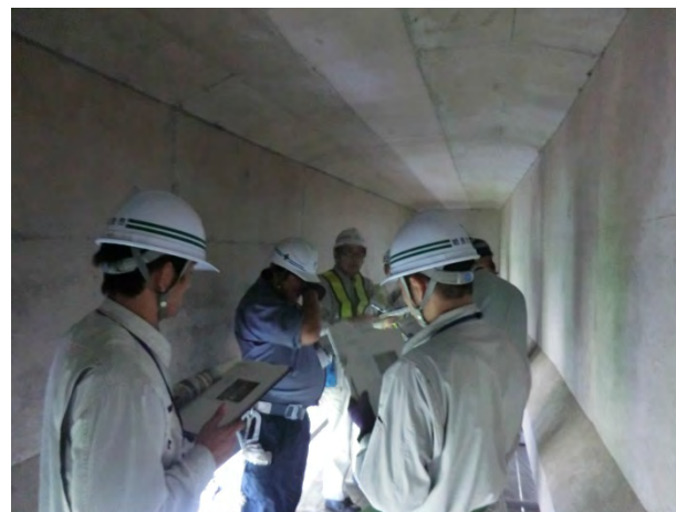
損傷の説明状況
