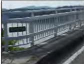
防護柵取替後
