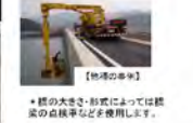
・橋の大きさ・形式によっては橋梁の吊橋車などを使用します。
