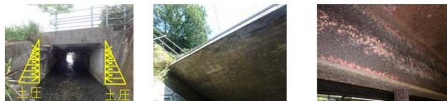
▲溝橋 ▲RC単純床版橋 ▲単純H形鋼桁橋
