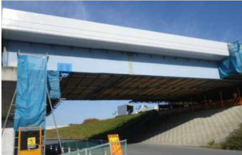
橋梁点検と補修工事で足場を共有
