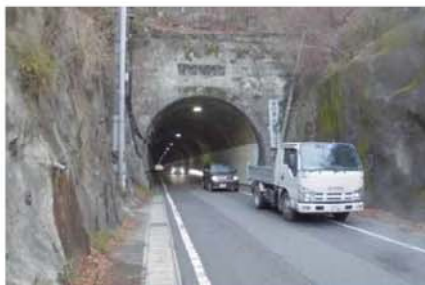
＜仁方隧道の状況＞
