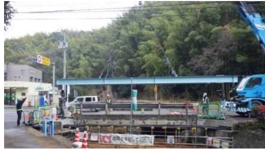
クレーンで主桁を撤去して支承を補修 主桁は工場で補修し再架設
