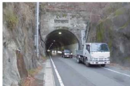
<仁方隧道の状況>
