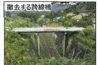
老朽化が進んだ跨線橋を撤去し隣接橋へ機能を集約
