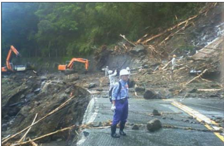
平成24年九州北部豪雨 国道57号滝室坂 斜面崩壊現場の診断状況
