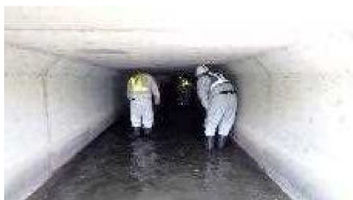
桁下空間が狭い箇所等 における近接目視
