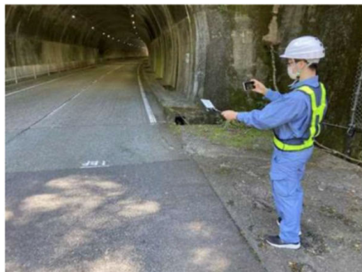
目視により路面性状を確認
