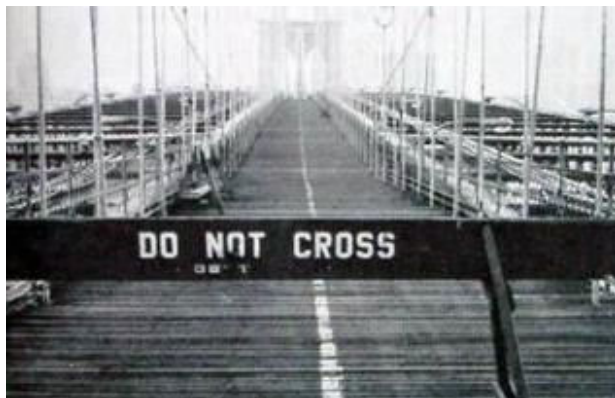
ケーブル切断事故後、通行止になったブルックリン橋の歩道 （「高速道路と自動車」1981年11月から引用）
