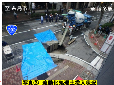
写真③ 流動化処理土投入状況
