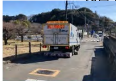
(空洞探査車による調査)
