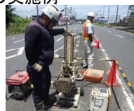
(貫入試験による調査)
