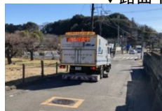
(空洞探査車による調査)
