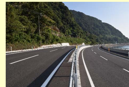
▲ 4車線供用区間 鹿児島市吉野町大崎地区付近
