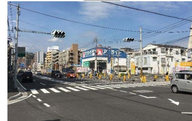
滞留区間設置、右折矢印白線表示、車線拡幅(+1.5m)
