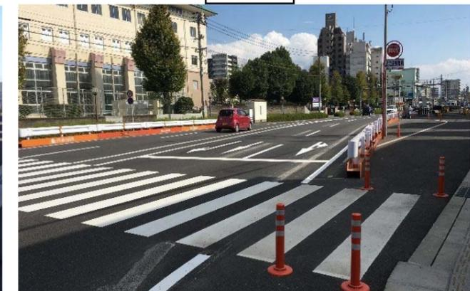
滞留区間設置、右折矢印白線表示、車線拡幅(+0.95m)
