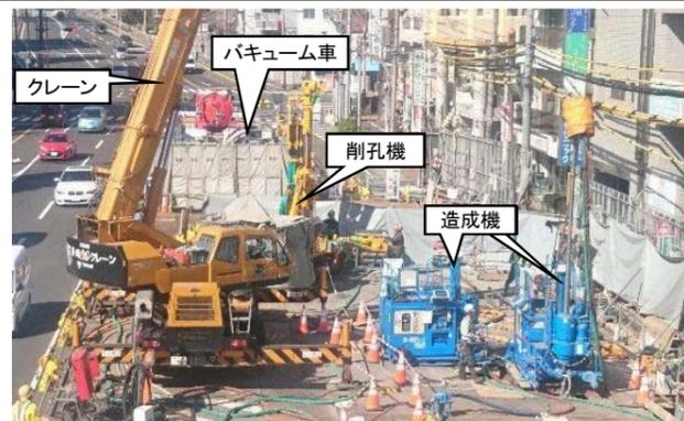
地盤改良工(上之園側作業帯での施工状況)
