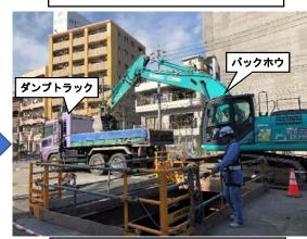
④土をダンプトラックに積み込み場外へ 搬出する
