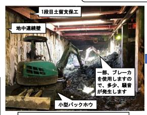
①立坑内を小型バックホウで掘削し、土 を集積する
