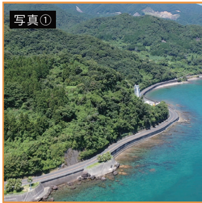
▲急峻斜面下の入り組んだ海岸線に沿う道路
