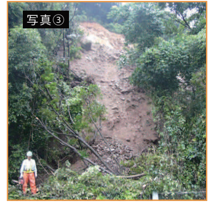
▲斜面の崩壊(H20.6)
