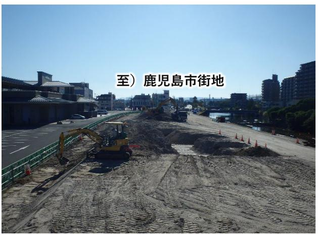
工事状況 地盤改良体の杭頭処理をしています。
