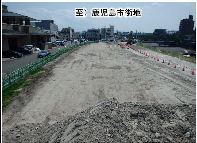
工事状況 地盤改良に支障になる転石除去完了。
