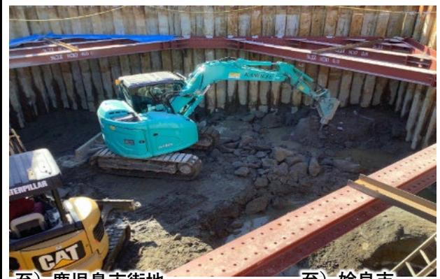
工事状況 土留め鋼矢板内の床掘りをしています。
