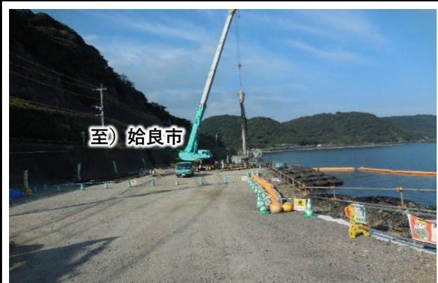
工事状況 土留め鋼矢板内の施工中です。
