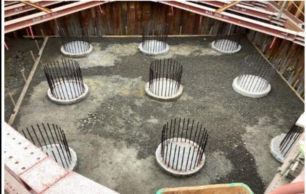
工事状況 場所打ち杭の杭頭処理が完了しました。
