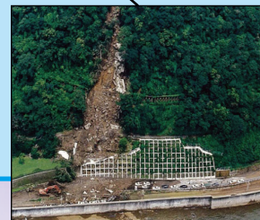
▲鹿児島市吉野町付近 斜面崩壊状況(H5.8)
