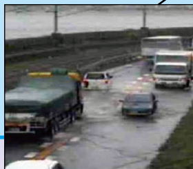
▲鹿児島市吉野町付近 冠水状況(H24.7.19)
