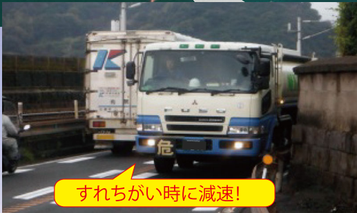
▲狭幅員箇所（大型車の離合困難）【車道幅員=5.7m】
