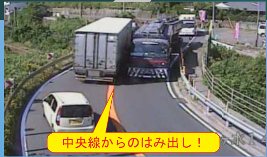
▲S字クランク箇所（大型車の離合困難）
