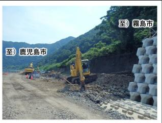
工事状況 基礎コンクリートを施工するため床堀中です。
