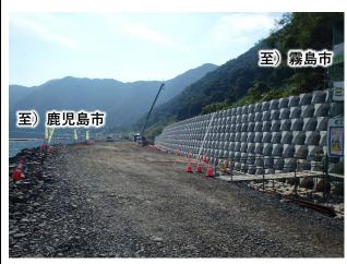
工事状況 根固めブロックを設置するため床堀中です。
