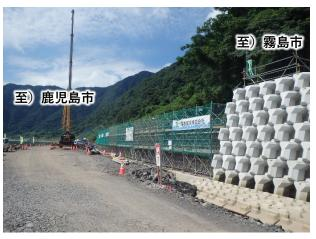
工事状況 腹付けコンクリートの型枠組立中です。
