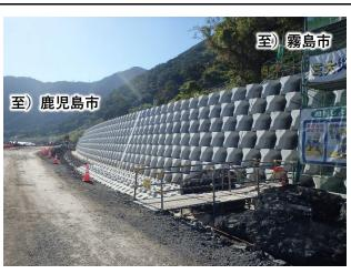
工事状況 根固めブロック施工中です。
