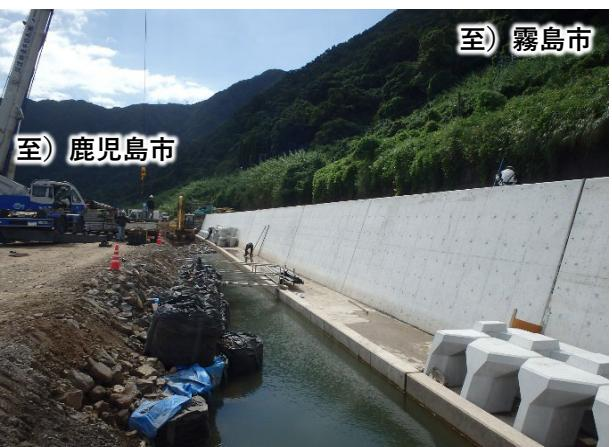
工事状況 腹付けコンクリート設置完了です。
