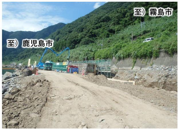
工事状況 腹付けコンクリート打設中です。
