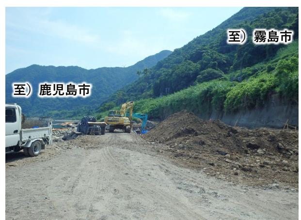
工事状況 基礎コンクリートを施工するため床掘中です。
