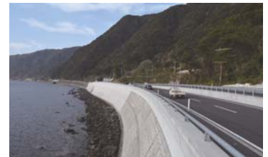
▲ 4車線供用区間 (H29.2.7) 鹿児島市吉野町大崎地区付近
