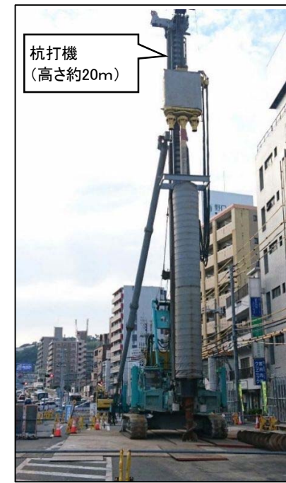
杭打機組立完了
