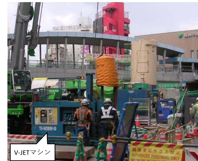
V-JET施工状況(他工事での施工状況)
