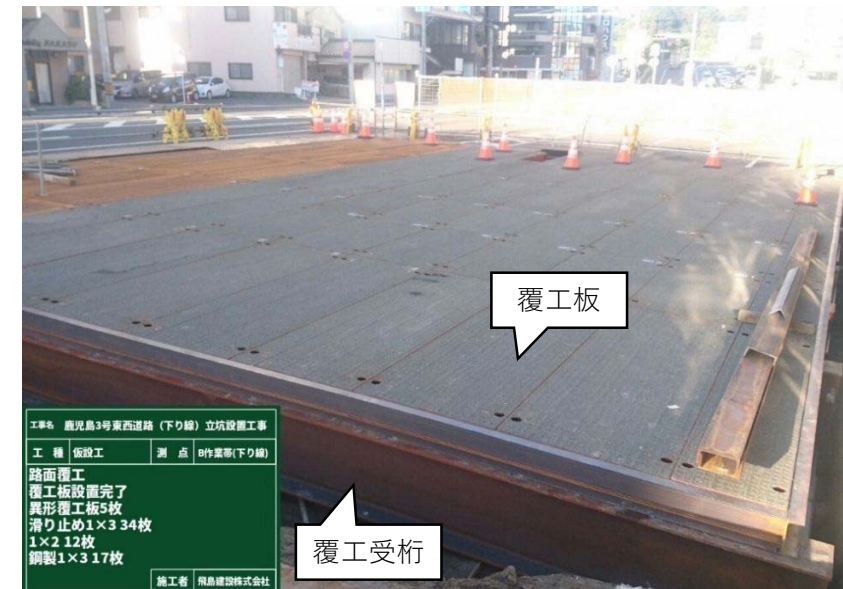
路面覆工(覆工板設置完了)
