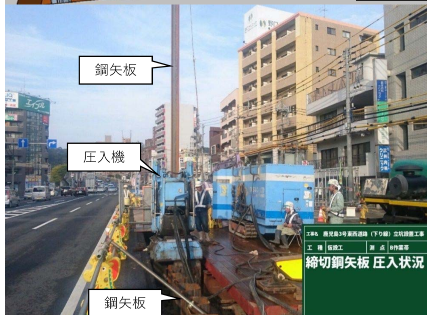
締切鋼矢板圧入状況
