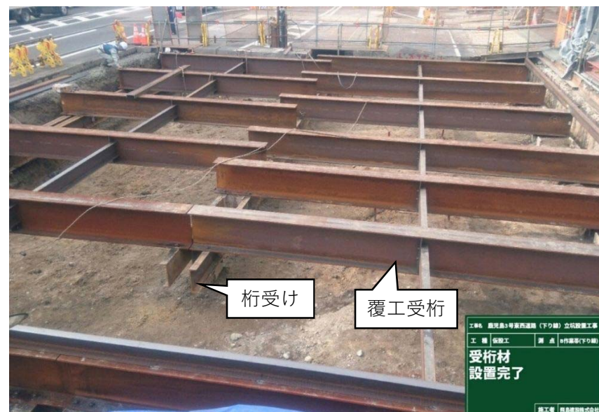
路面覆工(桁受け、覆工受桁設置完了)
