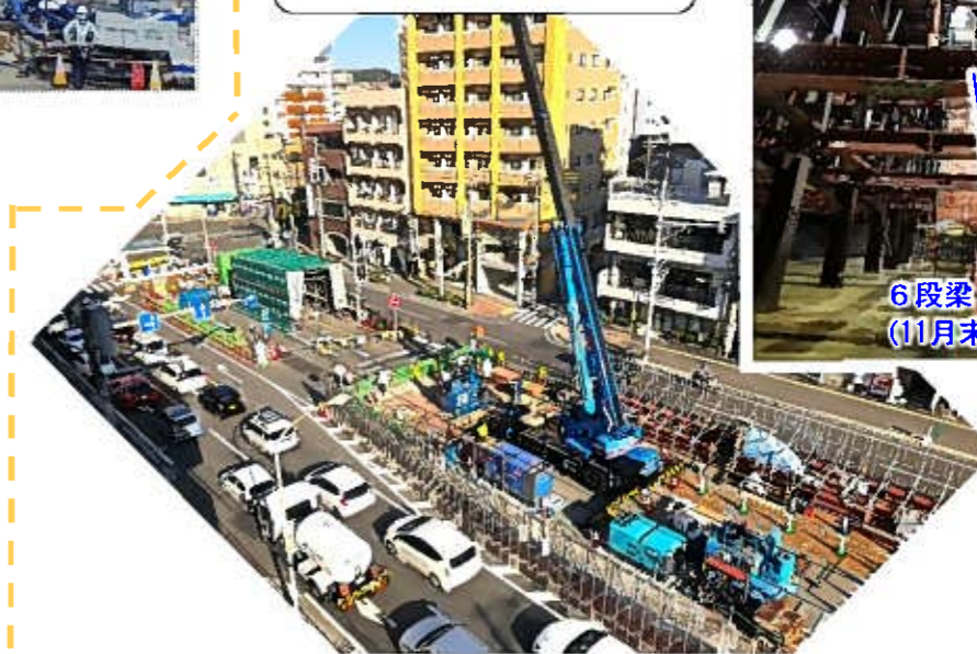
高圧噴射攪拌(鉛直方向) 施工状況
