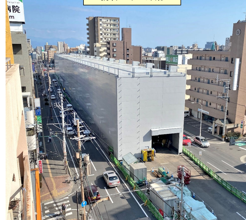
防音ハウス外観
