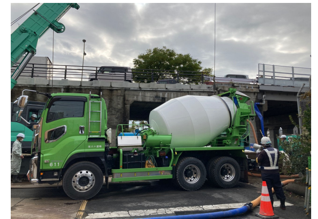
▲橋脚基礎杭撤去部埋戻し状況
