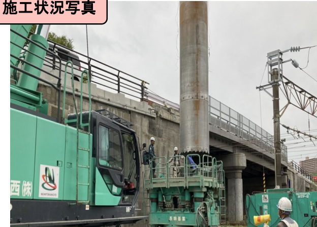
▲橋脚基礎杭撤去状況
