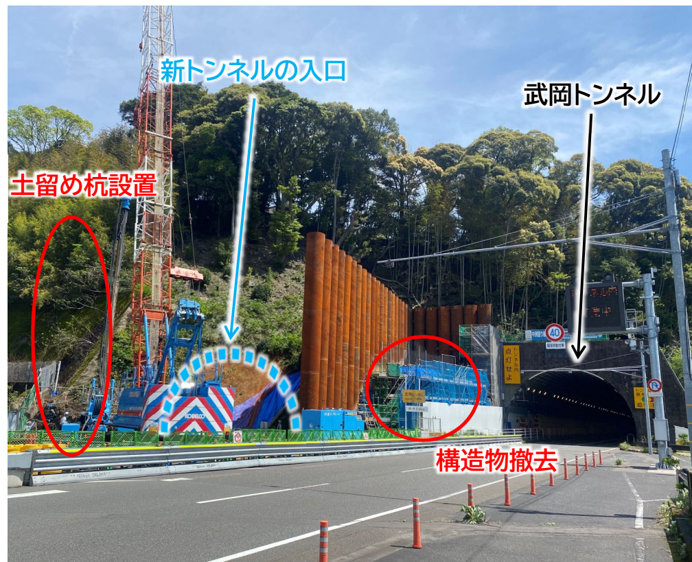
既設構造物撤去状況
