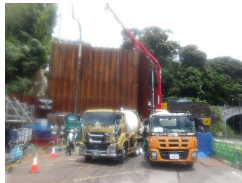
コンクリート打設作業状況
