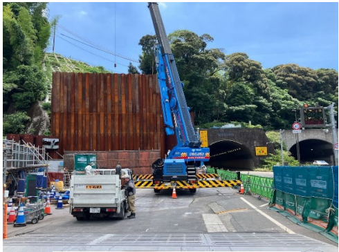
擁壁支柱設置作業状況
