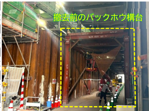
撤去前のバックホウ構台
