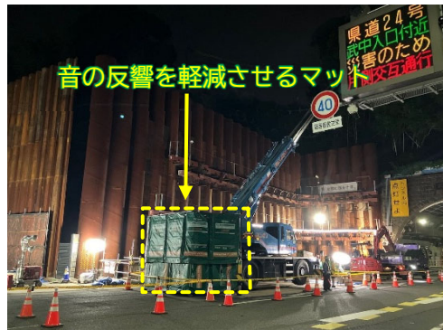
騒音防止対策（夜間）
