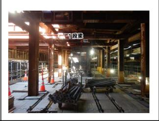
工事状況 7 リフト打設完了、2段目切梁撤去完了
