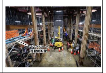
工事状況 側壁コンクリート打設中(2リフト)
