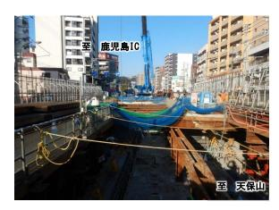
工事状況 中間杭受替、覆工板撤去中
