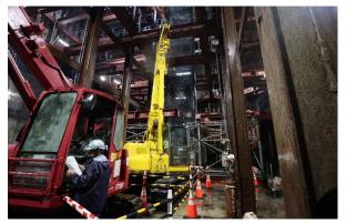
工事状況 3段目、4段目切梁撤去中
