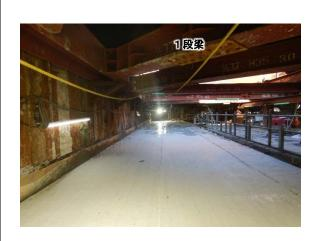
工事状況 8リフト打設完了(かまち梁・スラブ)
