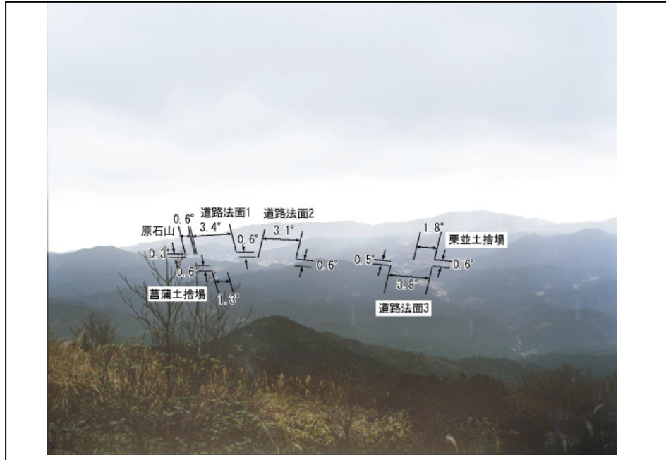
写真 3.4.2-1(3) 雷山からの眺望景観における影響要因の視角の程度
