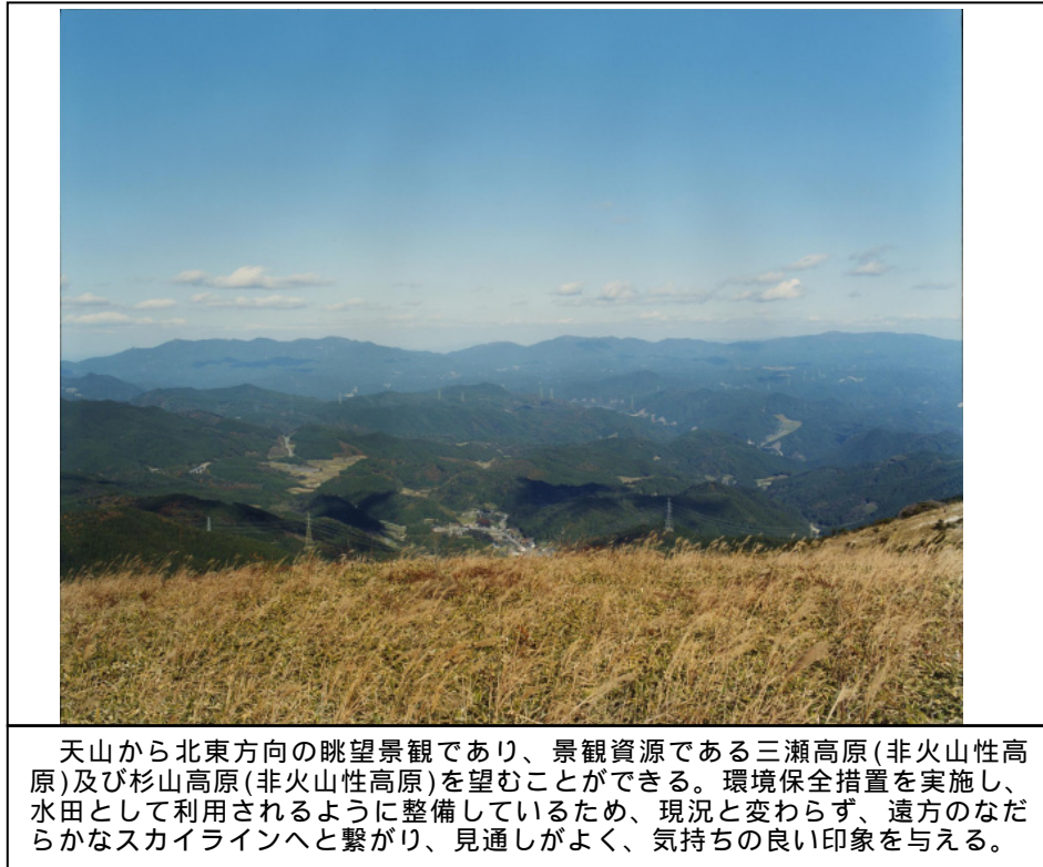
写真 4.1.8-6(3) 天山からの眺望景観の状況(環境保全措置実施後)
