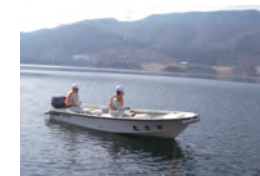
貯水池内の巡視
