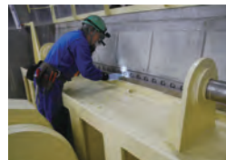
ゲートの点検
