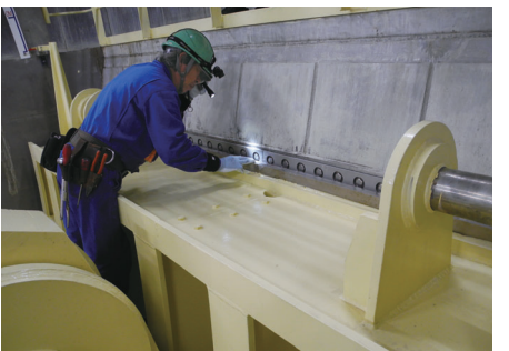
ゲートの点検
