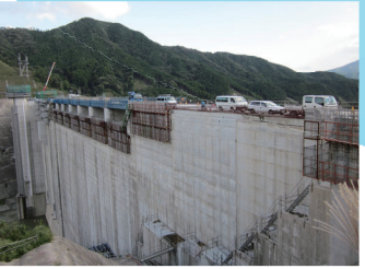
平成22年10月 本体工事中
