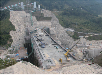
平成20年11月 本体工事中
