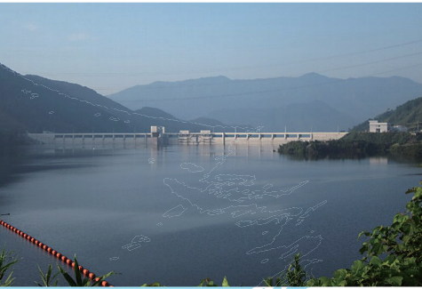
平成23年8月 試験湛水中
