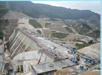
平成21年3月 本体工事中
