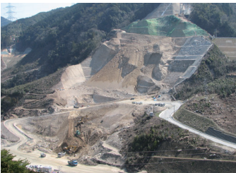
平成18年3月 基礎掘削工事
