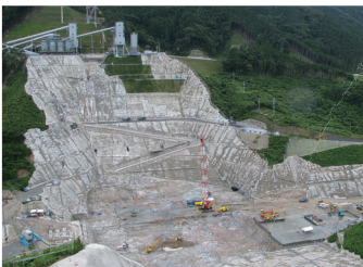
平成19年6月 基礎掘削工事
