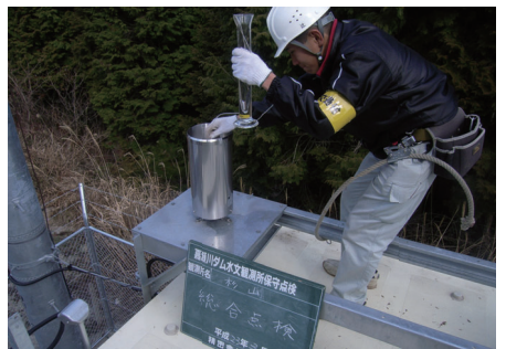
雨量観測所の点検
