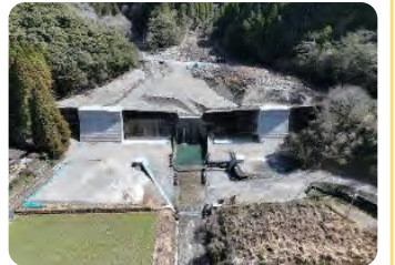
砂防えん堤の整備
