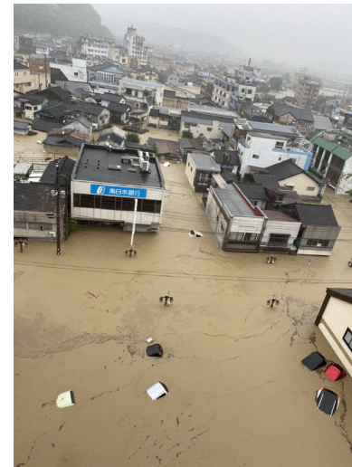
人吉市街地の浸水状況
