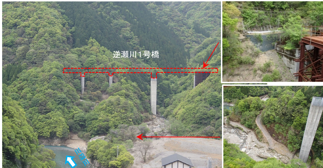
② 付替村道(逆瀬川1号橋)
