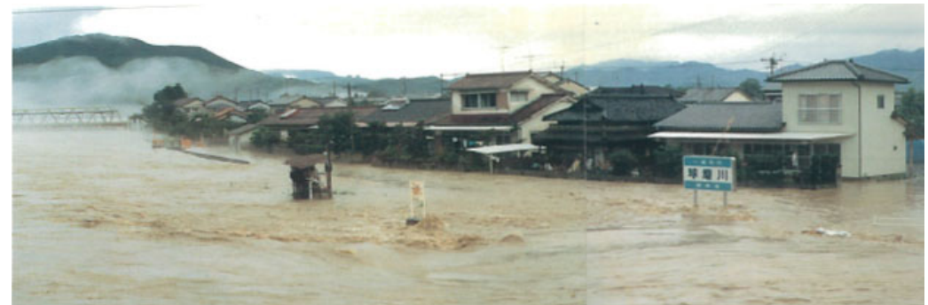
織月大橋下流の浸水状況
