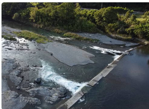
井手山堰の状況
