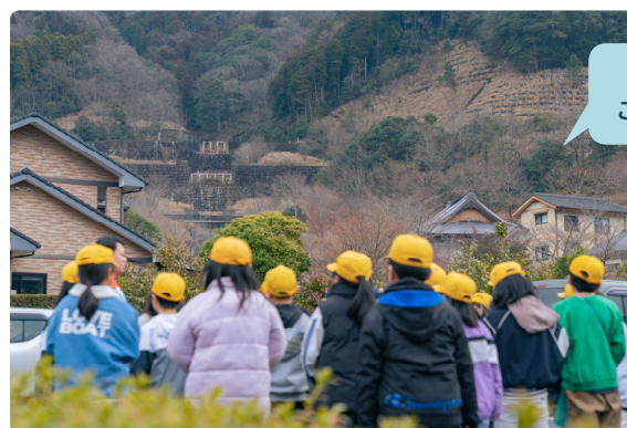
道の駅から砂防堰堤を望む
