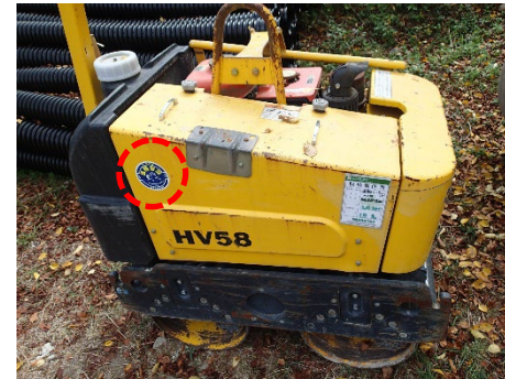
低振動・低騒音型建設機械が 適切に使用されているか確認
