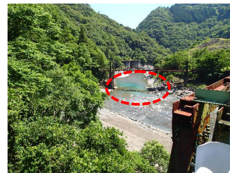
シルトフェンスが適切に設置されているか確認
