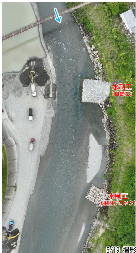
水制工周辺状況
