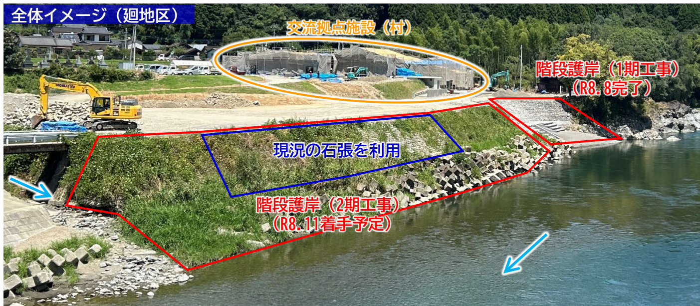
施工状況 (階段護岸)
