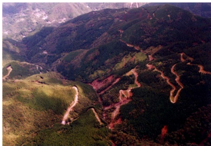
山の津谷川の山腹崩壊の状況 (平成 17 年 9 月 12 日撮影)
