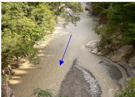
川辺川(吐合橋上流)の状況 (平成 17 年 9 月 19 日撮影)
