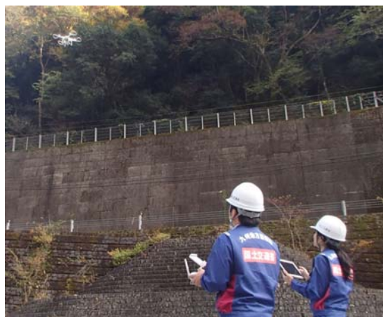
UAV調査状況
