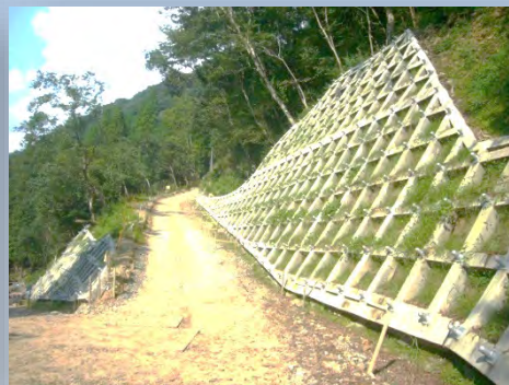
工事用道路起点側より撮影
