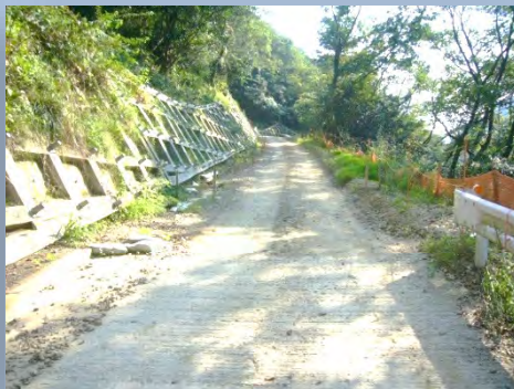
工事用道路終点側撮影
