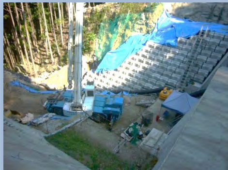
砂防堰堤上流側より撮影
