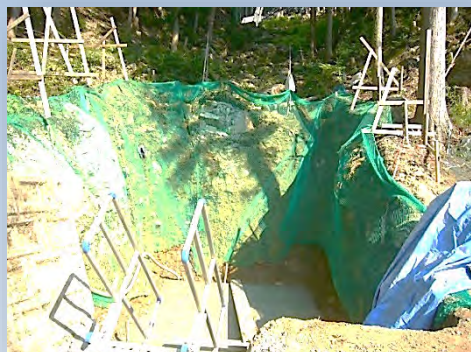
砂防堰堤下流側より撮影
