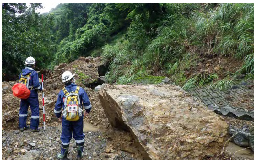
【球磨郡球磨村:被災状況調査(道路班)】
