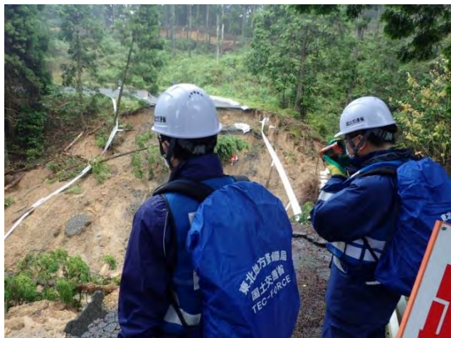
【応急対策班：被災状況調査（多良木町）】
