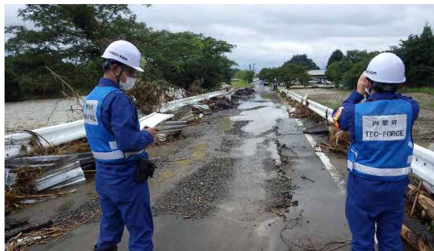
【被災状況調査】
