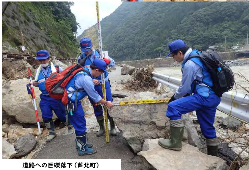
道路及び沿線線路の洗掘(芦北町)
