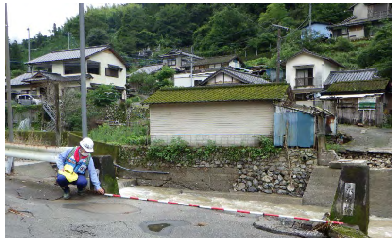
【球磨郡球磨村:被災状況調査(砂防班)】
