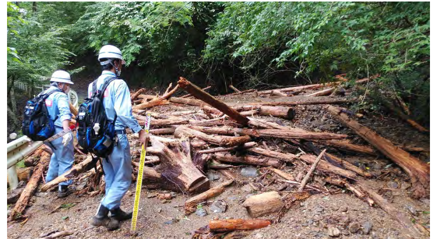
五木村道での被災状況調査
