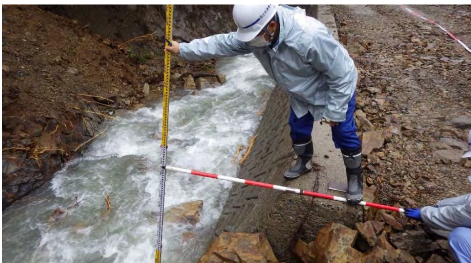
被災状況を調査（熊本県湯前町）
