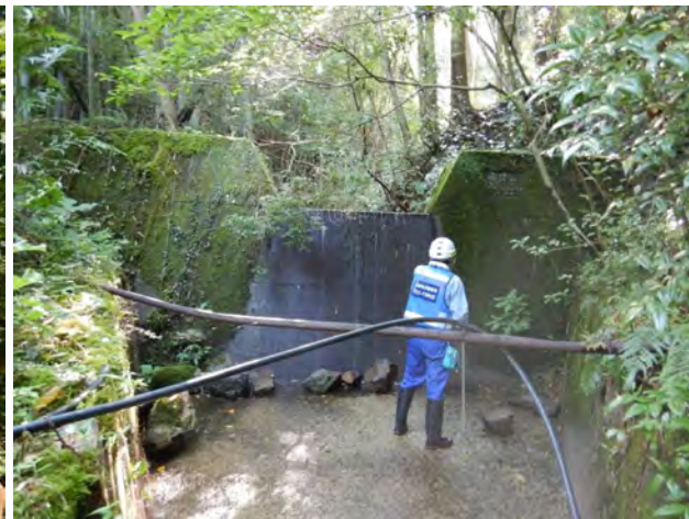
小森地先 現地状況 (土石流危険溪流の状況確認)
