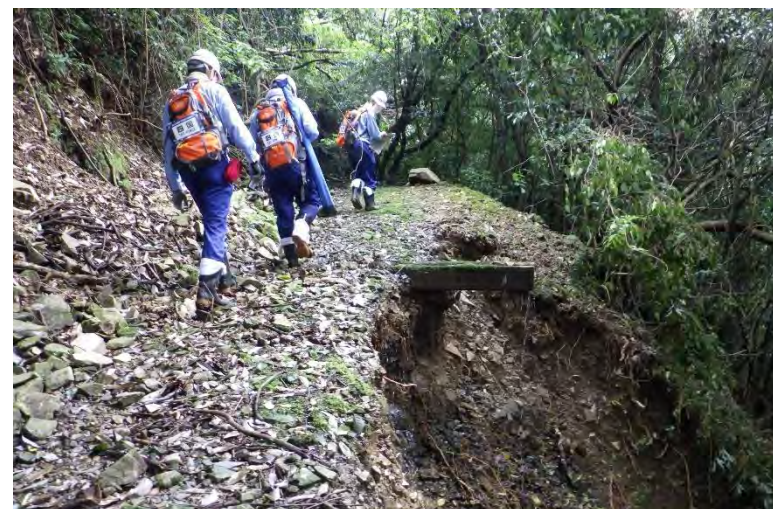
【球磨郡錦町:被災状況調査(河川班)】
