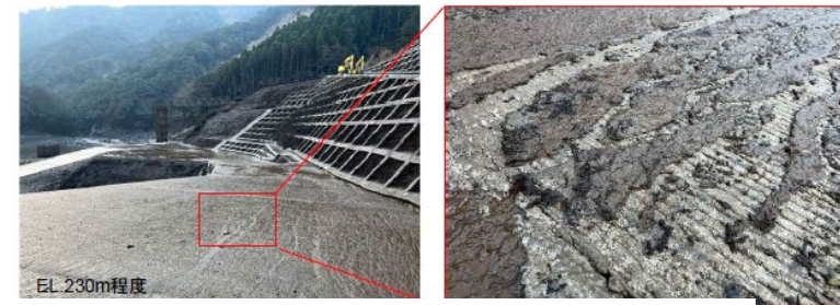
現地(管理用道路)の状況(堆積厚1cm未満)
