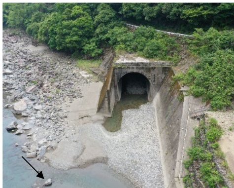
仮排水路トンネル吐口
