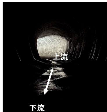
仮排水路トンネル内
