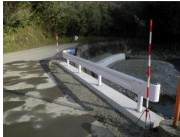
⑤ガードレール交換、根継ぎ工事(旧県道宮原五木線)
