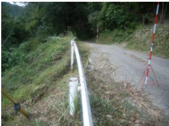
④ブロック積補修(旧国道445号)
