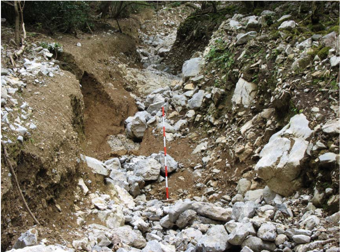
田口砂防えん堤より約500m上流の溪流の状況
