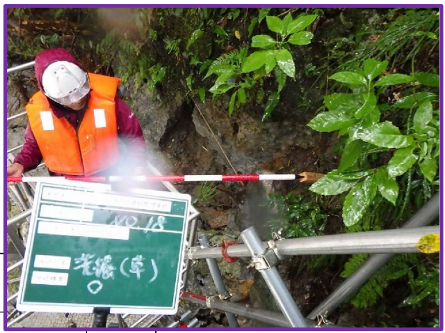
痕跡水位調査状況
